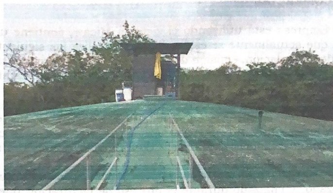
Ilustración 7. Caseta de Cloración
